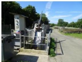
De façon épisodique, il existe un bruit d'eau au niveau du dégrilleur. il s'agit d'un relèvement. Ce bruit est bien plus faible que le bruit du bassin d'aération. Son influence est négligeable au droit des tiers.
